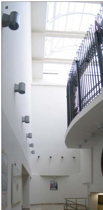
Рис. 5. Освещение главной лестницы: а – нижнего уровня через световую шахту; б – верхнего уровня
