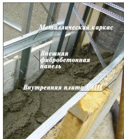
Рис. 3. Конструкция стены малоэтажного дома
