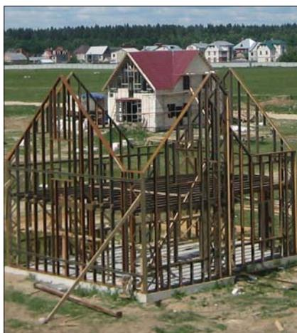
Рис. 2. Металлический каркас из ЛСТК устанавливается на металлической плите
