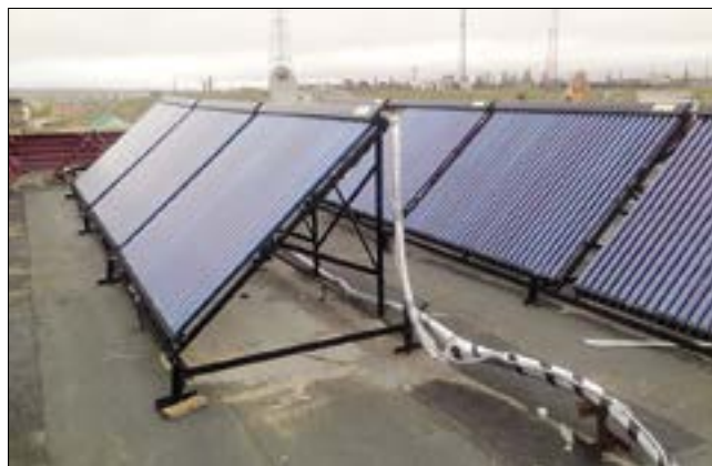
Рис. 4. Внешний вид системы на покрытии многоквартирного дома в с. Борогонцы
