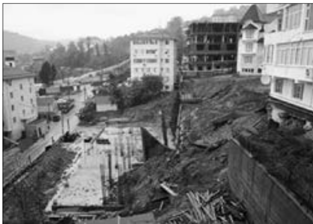
Рис. 1. Последствия оползня при разрушении подпорной стены (Сочи, ул. Виноградная, 195/16)
