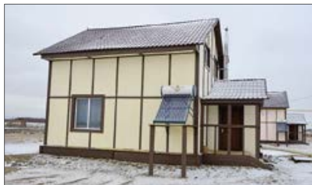
Рис. 2. Фасад жилого дома с малым солнечным коллектором в с. Аппаны
