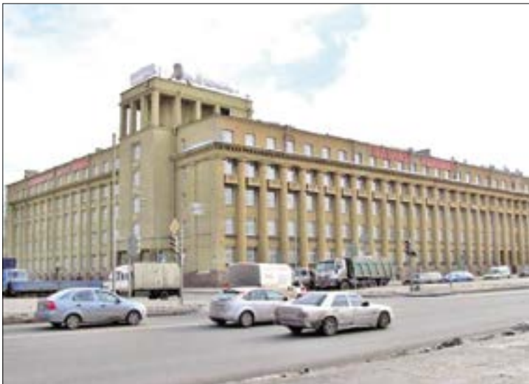
Рис. 2. Заневский пр., д. 2. Одно из административных зданий на предмостной площади
