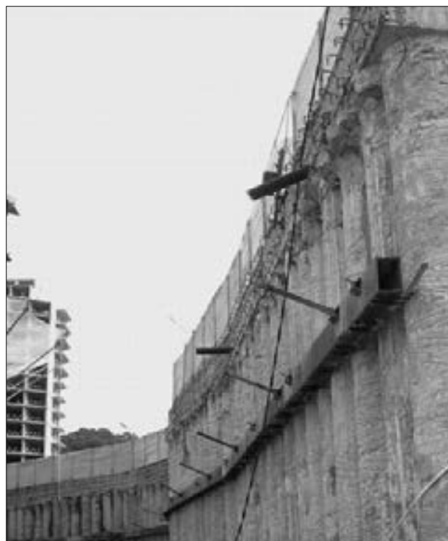
Рис. 9. Общий вид удерживающих сооружений
