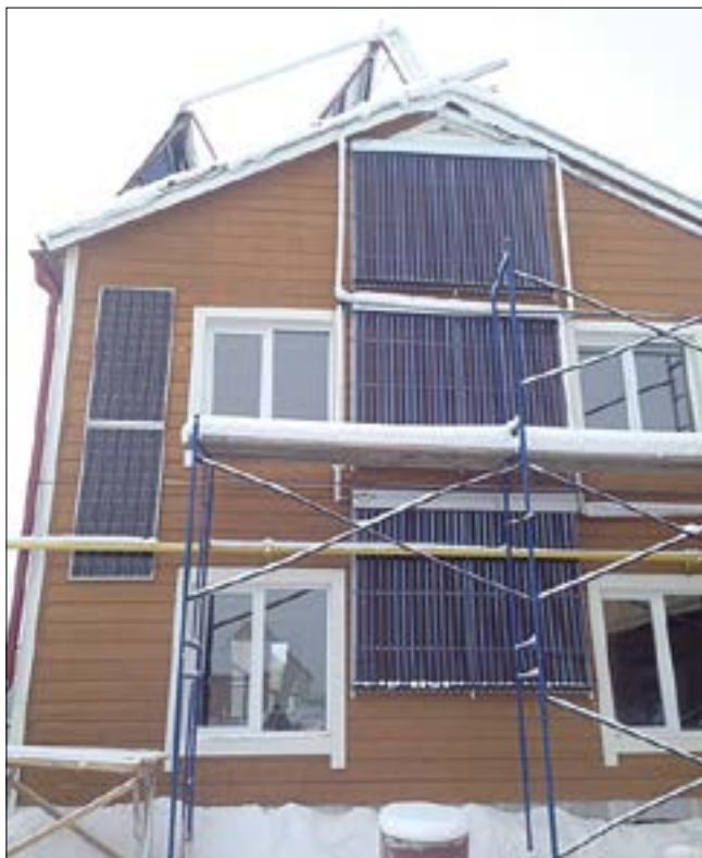
Рис. 5. Восточный фасад экспериментального дома в г. Якутске
