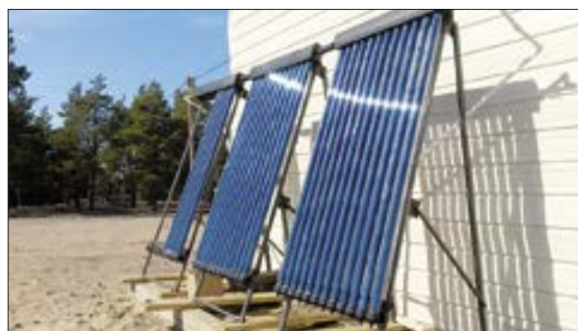
Рис. 3. Фасад жилого дома с солнечным коллектором в г. Вилюйске
