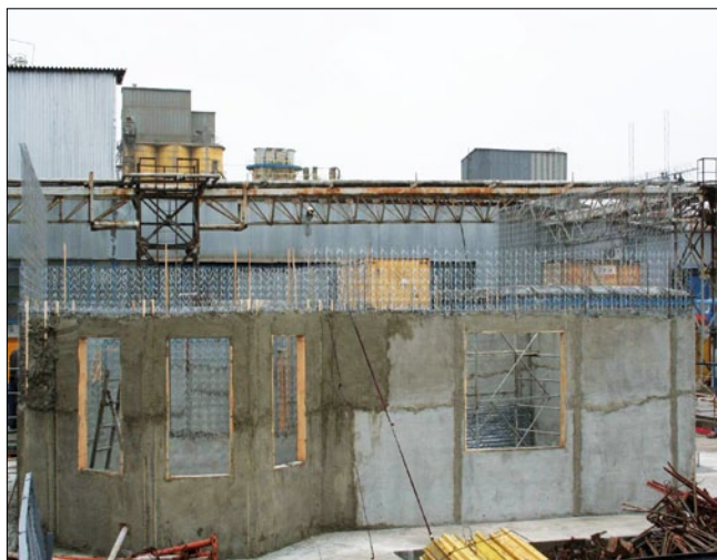
Арматурный каркас второго этажа 0716
