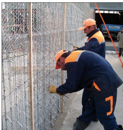
Монтаж каркаса
