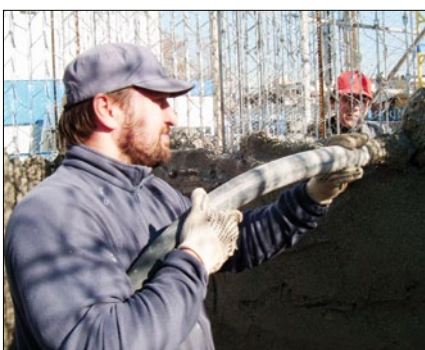
Механизированное заполнение каркаса пенополистирольной смесью 0535
