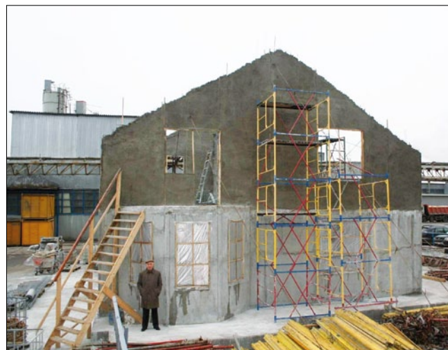
Готовые стены и фронтон второго этажа
