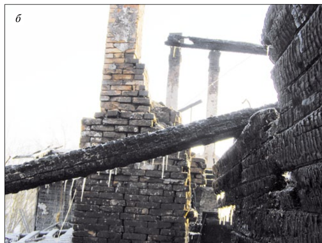
Рис. 2. Общий вид здания после взрыва (а) и последующего пожара; высокие кирпичные трубы (б) без поддержки деревянных конструкций крыши представляют опасность из-за пониженной устойчивости
