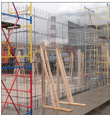
Монтаж каркаса
