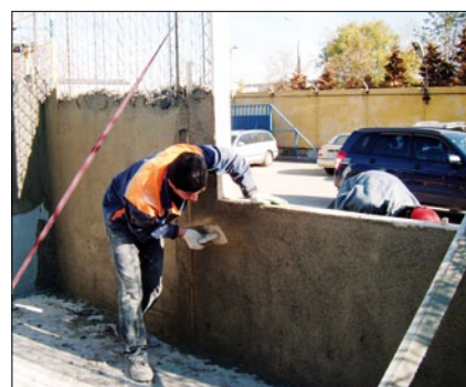
Выравнивание и заглаживание смеси 0622, 0569,0458
