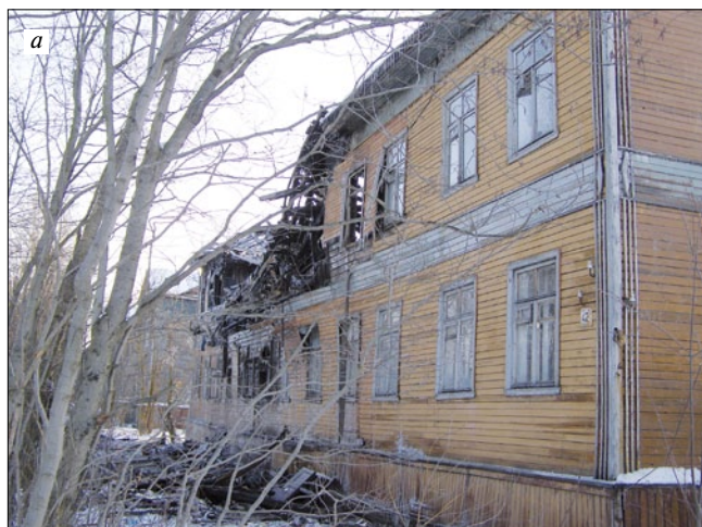
Рис. 2. Общий вид здания после взрыва (а) и последующего пожара; высокие кирпичные трубы (б) без поддержки деревянных конструкций крыши представляют опасность из-за пониженной устойчивости
