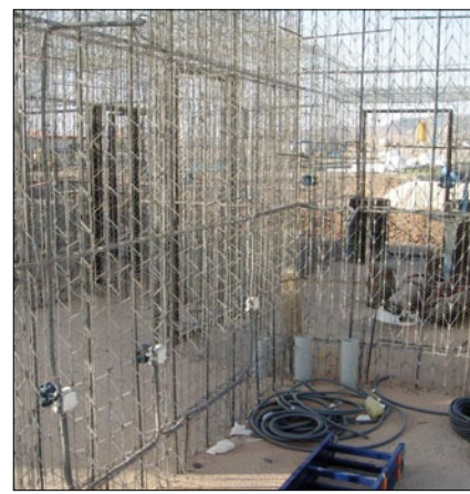
Прокладка электрокоммуникаций в каркасе 3430
