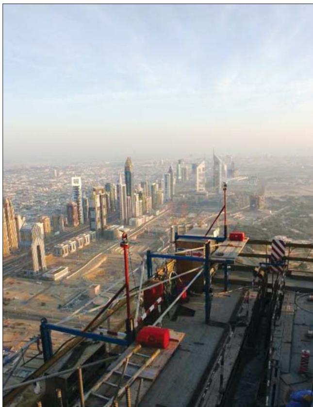
Рис. 3. Геодезическое оборудование на передвижной бетонной опалубке
