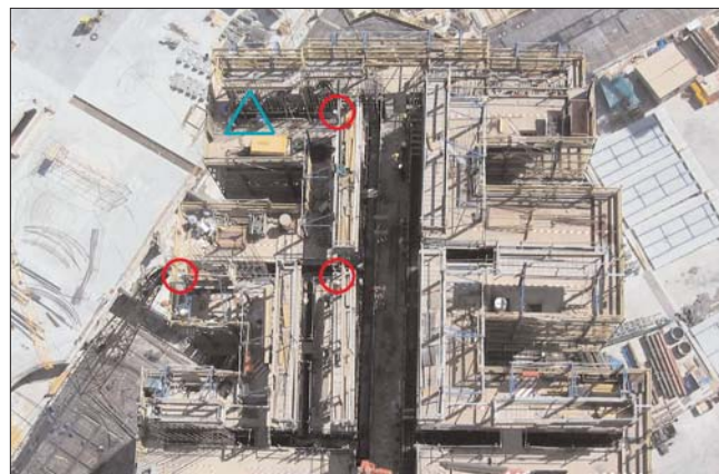
Рис. 6. Монтажный горизонт: \Delta — место установки тахеометра; \circ — место установки антенны
