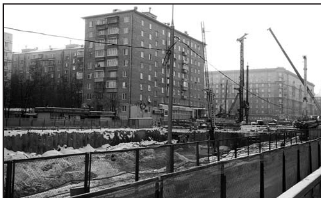
Строительство Алабяно-Балтийского тоннеля (январь 2010 г.)
