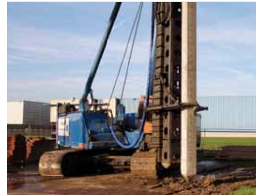
Забивка бетонной сваи на стройплощадке
