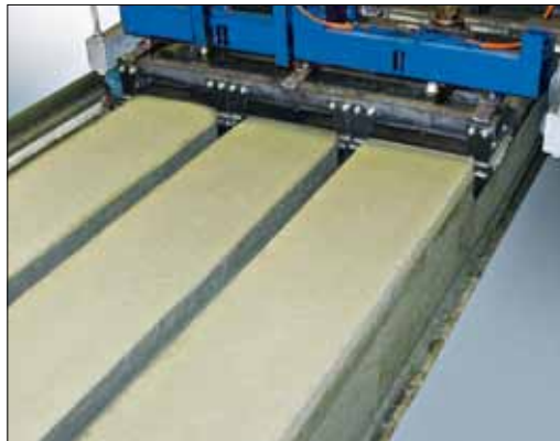
Компания Echo Precast Engineering разработала технологию, позволяющую на стандартном производственном настиле при помощи слипформера изготавливать сваи безопалубочным способом
