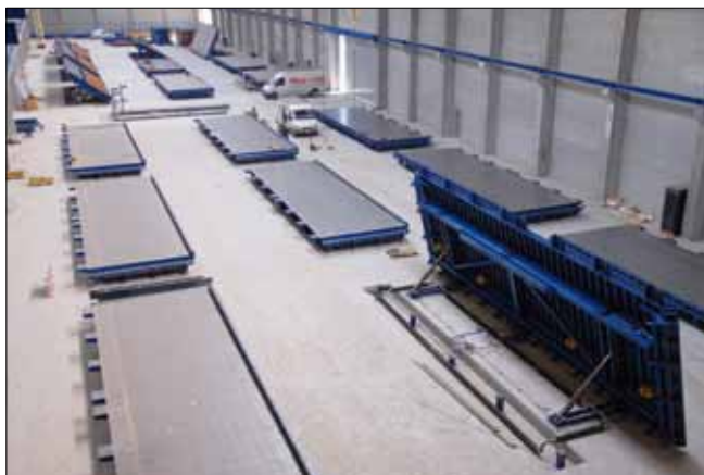
Проект с 61 гидравлическим поворотным столом на предприятии Concretop в Уденаарде (Бельгия)
