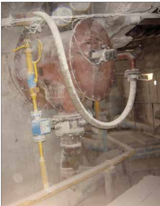
Рис. 4. Внешний вид тангенциальной горелки 4
