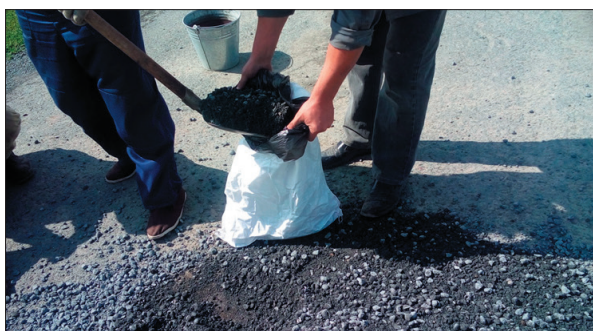
Рис. 6. Заготовка асфальтовой смеси с дисперсным битумом для ямочного ремонта Fig. 6. Preparation of asphalt mix with dispersed bitumen for patching
