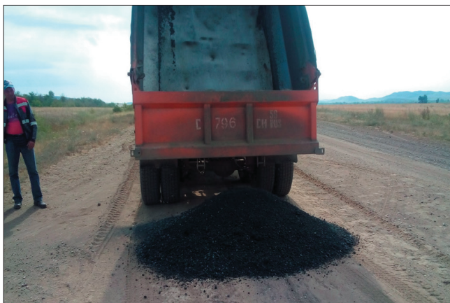
Рис. 3. Выгрузка асфальтовой смеси с дисперсным битумом на грунтовое основание Fig. 3. Unloading asphalt mix with dispersed bitumen on a soil base
