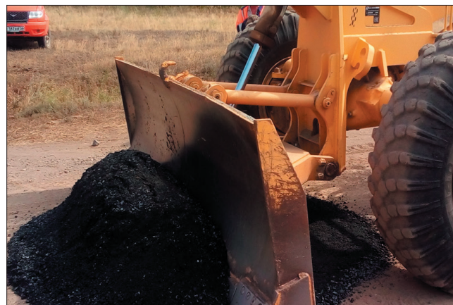
Рис. 4. Укладка асфальтовой смеси с дисперсным битумом на грунтовое основание Fig. 4. Laying asphalt mix with dispersed bitumen on a soil foundation
