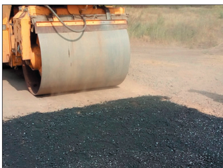
Рис. 5. Уплотнение катком асфальтовой смеси с дисперсным битумом Fig. 5. Roller compaction of asphalt mixture with dispersed bitumen
