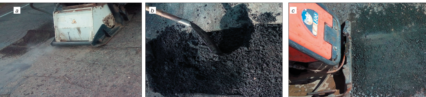
Рис. 7. Этапы ямочного ремонта асфальтовой смесью с дисперсным битумом: а – подготовка карты; б – заполнение карты смесью; с – уплотнение виброплитой Fig. 7. Stages of patching with asphalt mixture with dispersed bitumen: a – preparation of a map; b – filling the card with a mixture; c – vibration plate seal
