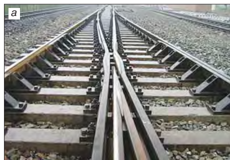
Рис. 7. Конструкции ж/б брусьев: а – ж/б брусья стрелочных переводов [60]; б – то же, мостовые [61] Fig. 7. Constructions of reinforced concrete beams: а – reinforced concrete beams of turnouts [60]; б – the same, bridge [61]
