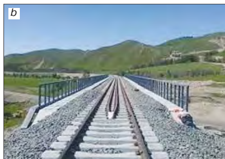
Рис. 7. Конструкции ж/б брусьев: а – ж/б брусья стрелочных переводов [60]; б – то же, мостовые [61] Fig. 7. Constructions of reinforced concrete beams: а – reinforced concrete beams of turnouts [60]; б – the same, bridge [61]
